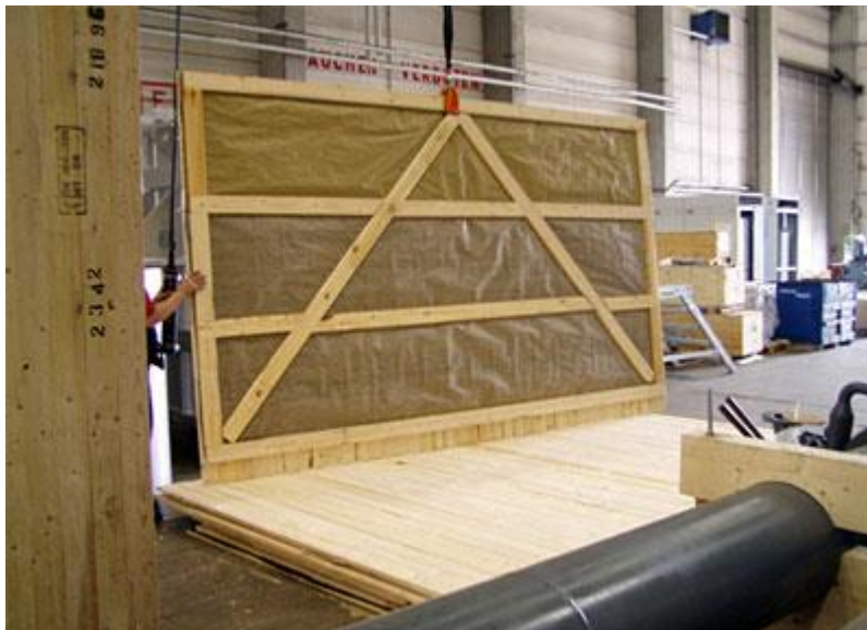
Abbildung 7: Seitenwand mit Sperrschicht ausgekleidet
